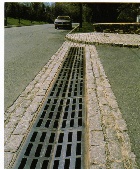
貯水溝のパイプへの排水溝のディテール Detail of inlet to storage pipes.
