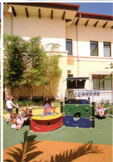
を重視し、ゴムチップの衝撃吸収材を採用した。すべての遊び場は、コンクリートとゴムチップなどの異なる素材の境目も含めバリアフリーにデザインされており、砂場の縁にもゴムチップを使い、垂直ではなく安全な角度に作られた。このカラフルなゴムチップの図柄と色の選択で、段差が空間を仕切らない代わりに、心理的に動線や空間を仕切ることができるよう工夫すると同時にそれぞれの遊び場にテーマを与えることができた。
